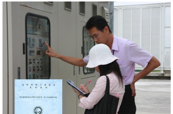
▲ 現場執行製程現勘作業
