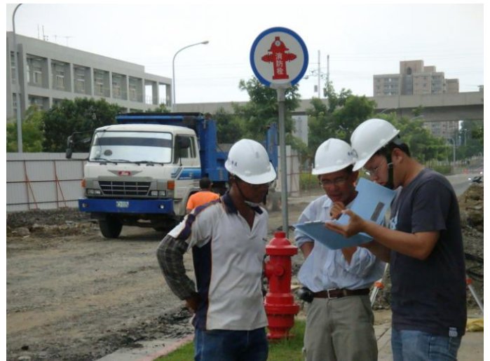
▲ 現場執行製程現勘作業
