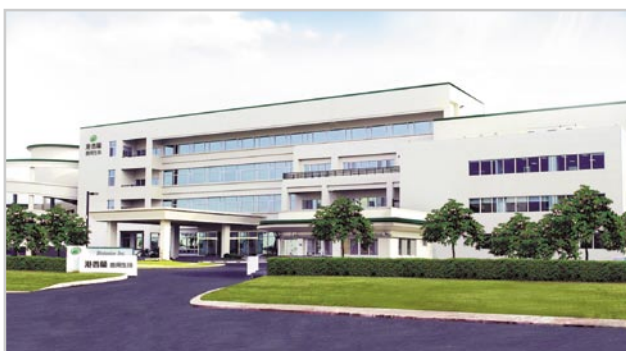
▲ 港香蘭公司生技廠房
