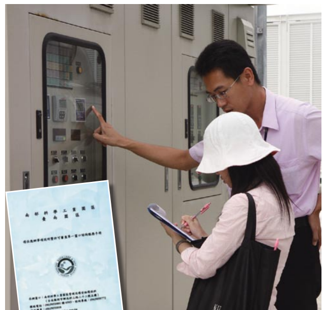
▲ 現場執行製程現勘作業
