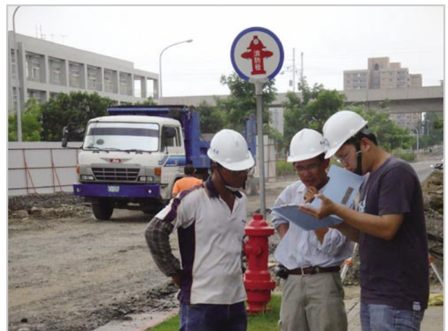
▲ 現場執行製程現勘作業
