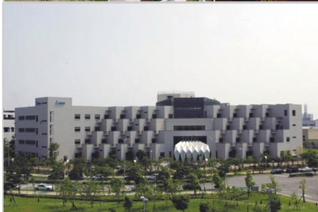
▲ 台達電公司科技廠房
