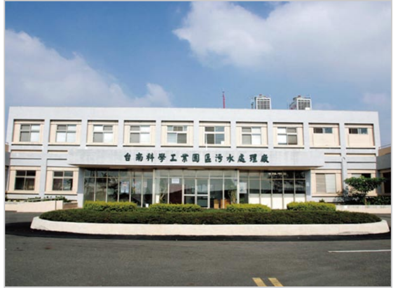
▲ 台南園區環工中心污水處理廠
