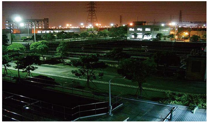
▲ 污水廠廠區部分景觀燈及路燈停用
