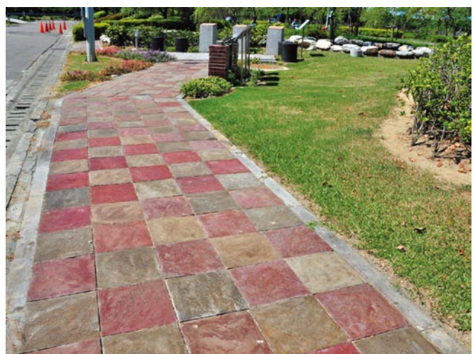
將廢水污泥製成磚品鋪設成人行道
